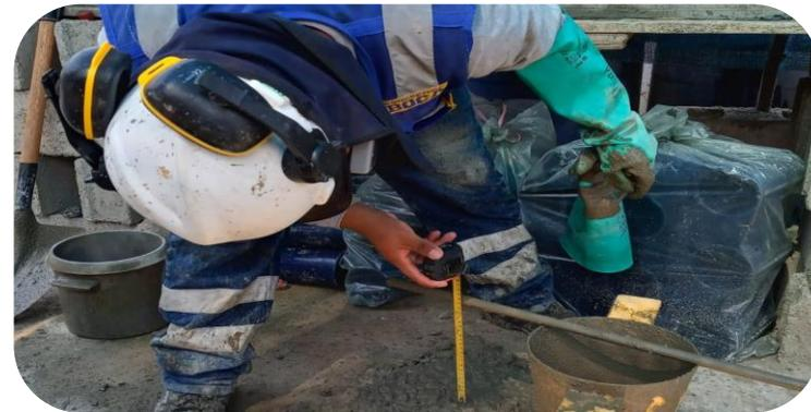
4. VERIFICACIÓN DEL SLUMP SOLICITADO DEL CONCRETO
